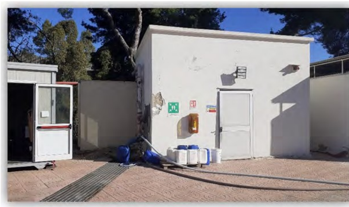
Figura 2 - Locale pompe- Lato SUD
