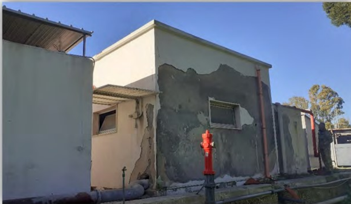
Figura 3 - Locale pompe Lato NORD
